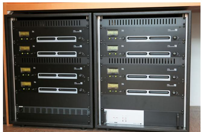
**Die Lautsprecher werden über Leistungsendstufen versorgt, die im Bereich der Regiekanzel untergebracht sind**
