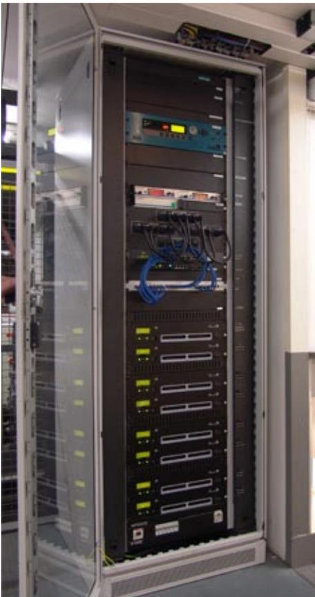
Gestellschrank mit Yamaha DME64 (grünes Gerät oben im Rack) und d&b Systemverstärkern
